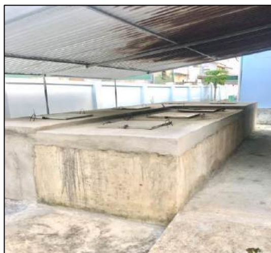
Hình 3.10. Bể chứa chất thải sắc nhọn tại TTYT huyện Hương Sơn
