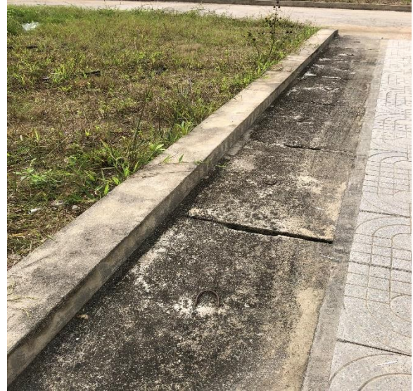
Hình 3.1. Mương thoát nước mưa tại TTYT
