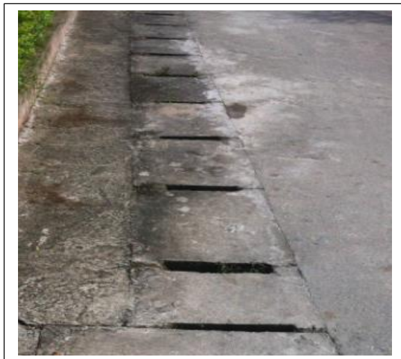
Hình 3.1. Mương thoát nước mưa tại Bệnh viện
