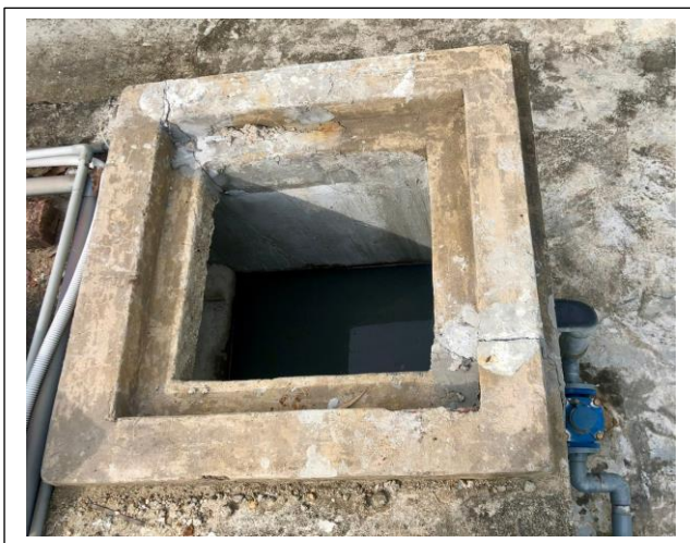
Hình 3.9. Bể khử trùng
