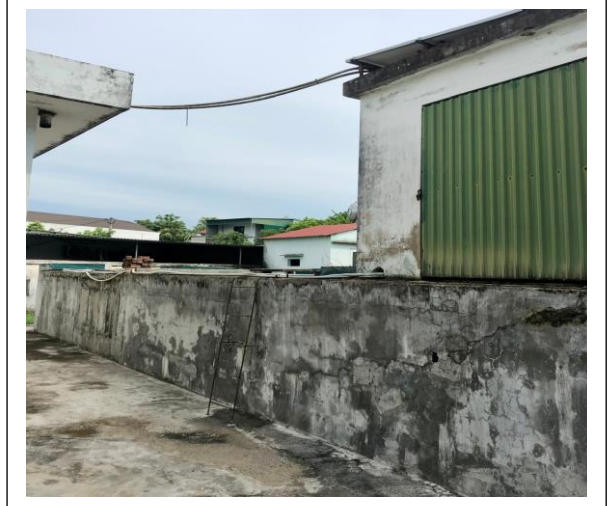
Hình 3.6. Khu xử lý nước thải
