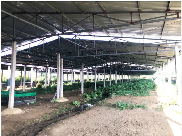
Hình 3.3. Mương đất thoát nước mưa
