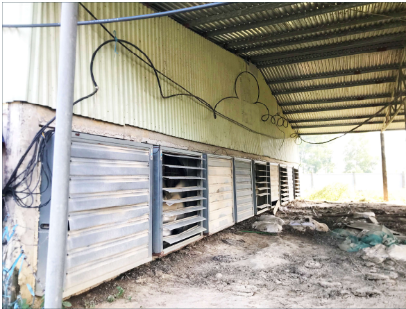
Hình 3.7. Hệ thống quạt hút và làm mát tại trang trại
