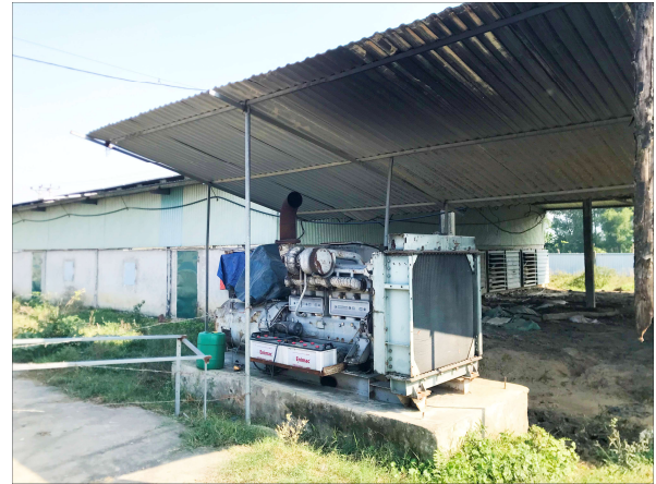
Hình 1.5. Máy phát điện dự phòng của trang trại
