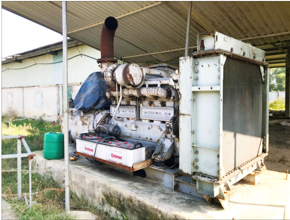
Hình 1.5. Máy phát điện dự phòng của trang trại
