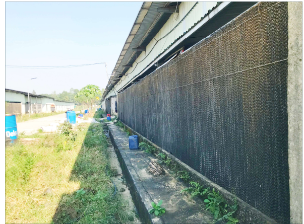
Hình 3.7. Hệ thống quạt hút và làm mát tại trang trại
