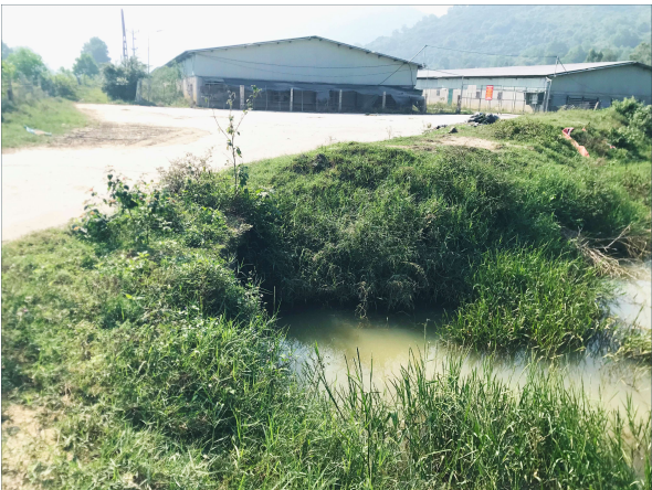
Hình 3.4. Điểm thoát nước mưa
