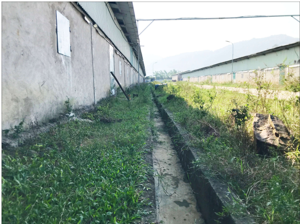
Hình 3.2. Hệ thống mương thoát nước mưa bằng bê tông
