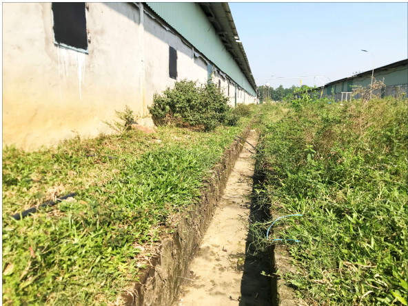
Hình 3.2. Hệ thống mương thoát nước mưa bằng bê tông
